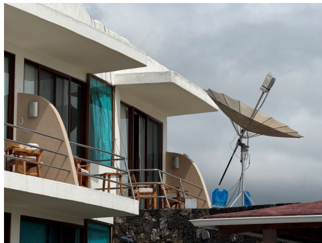
EME pracoviště HD8G v hotelu Sol y Mar
