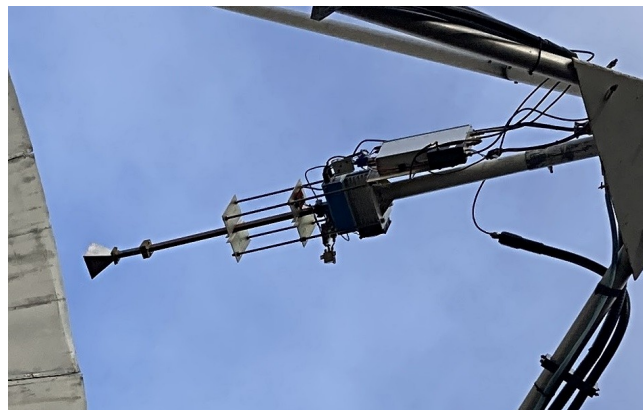
KL6M 3cm v ohnisku parabolky 9,2m
